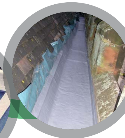
Соединения водосточных желобов
