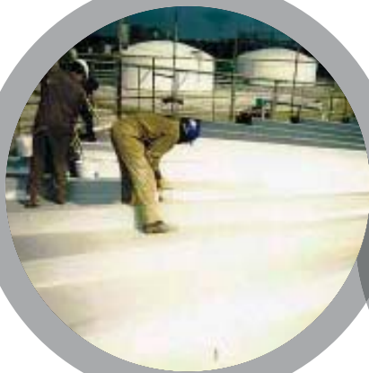
Герметизация изоляции
